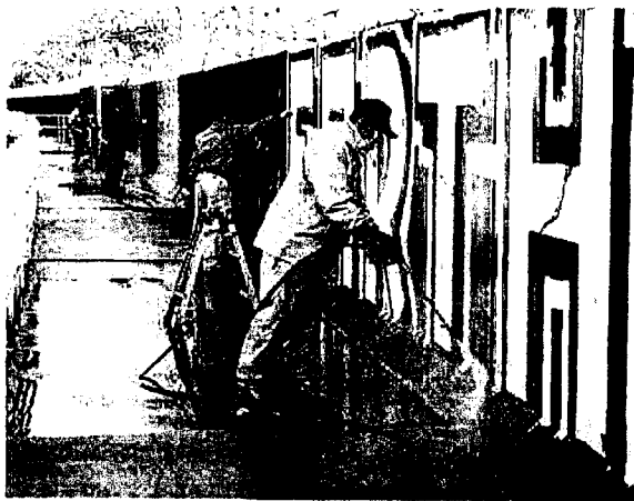
作業前に汚れを高圧洗浄で除去
